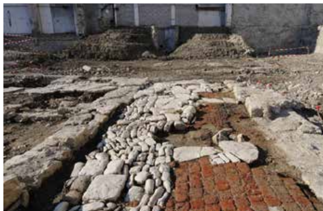
Vues du chantier © Dominique Delfino / SedD
