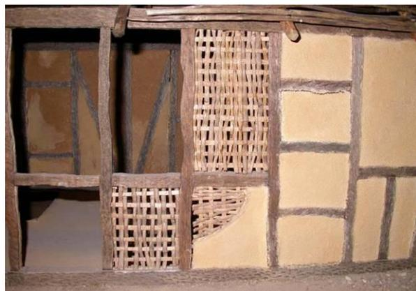
Les parois sont montées suivant la technique du **torchis sur clayonnage**. Le torchis, mélange de terre et de fibres végétales, est appliqué de part et d'autre d'une armature légère composée de branches souples entrelacées, appelée « clayonnage », elle-même disposée entre les poteaux. Sensibles à l'humidité, les murs, protégés par l'avancée du toit, sont fréquemment recouverts d'enduit de chaux.
