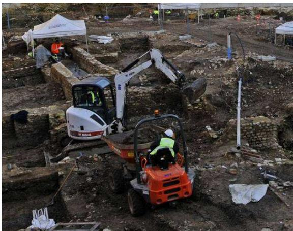
Une fois les repères spatiaux implantés, le **décapage du terrain** est réalisé à la **pelle mécanique**, souvent en association à la pioche et la pelle.
